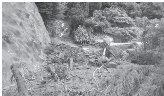
7月豪雨災害被災状況
